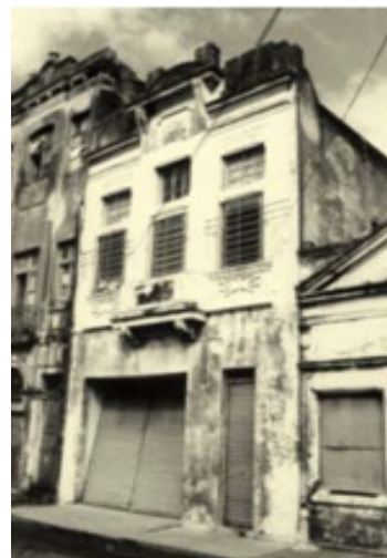
Imagem 22 - Nota-se o mesmo sobrado antes do processo de arruinação. Fonte: Giustina, 2010.
