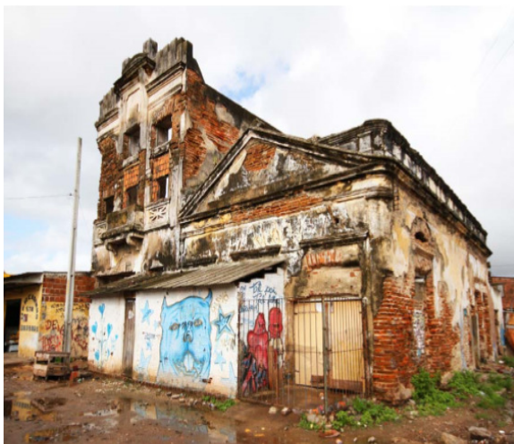
Imagem 21 - Ruína de Sobrado. Fonte: Fundação Seridó, Relatórios Técnicos, v. I, 2012.
